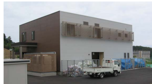
写真 1 エコセンター
